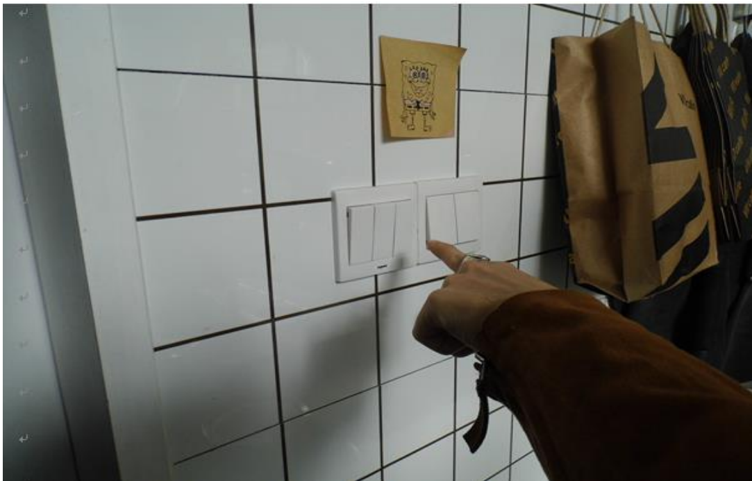
(图二) 室内墙面三联单项面板开关，从保留原状看是处于合闸开启状态（从事带电作业）。
