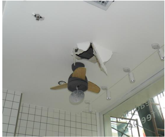
灯箱转换器安装位置
