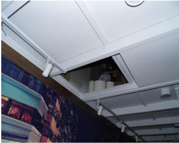
检修口入口处
